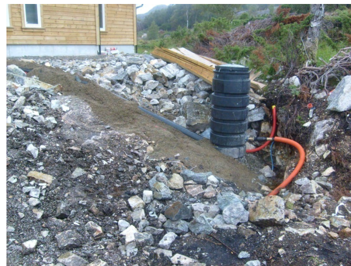
Selvfyll og trykkavløp med kvernpumpe
