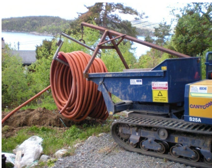
Isoterm rørutlegger for kveilrør
