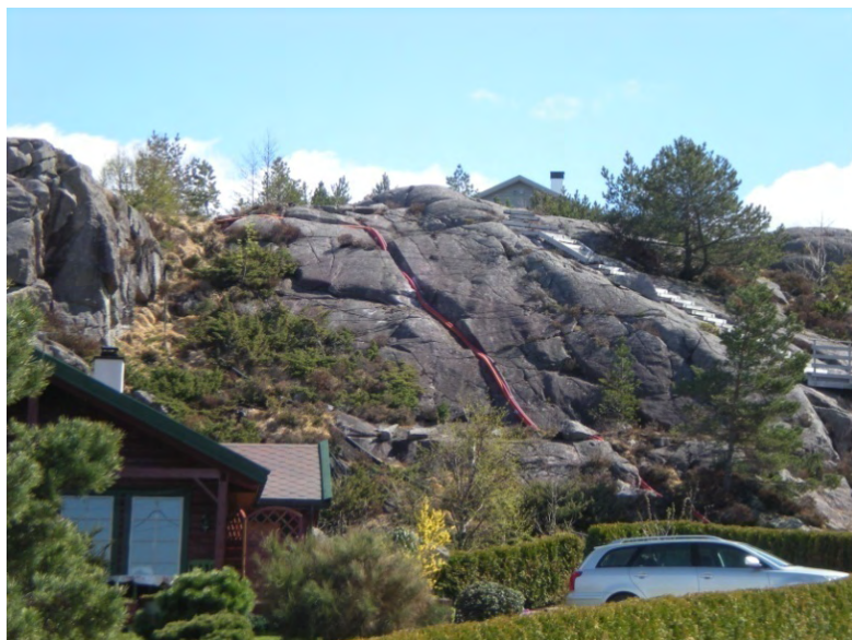
Rør lagt i bergsprekk Her vist før rør er tildekket
