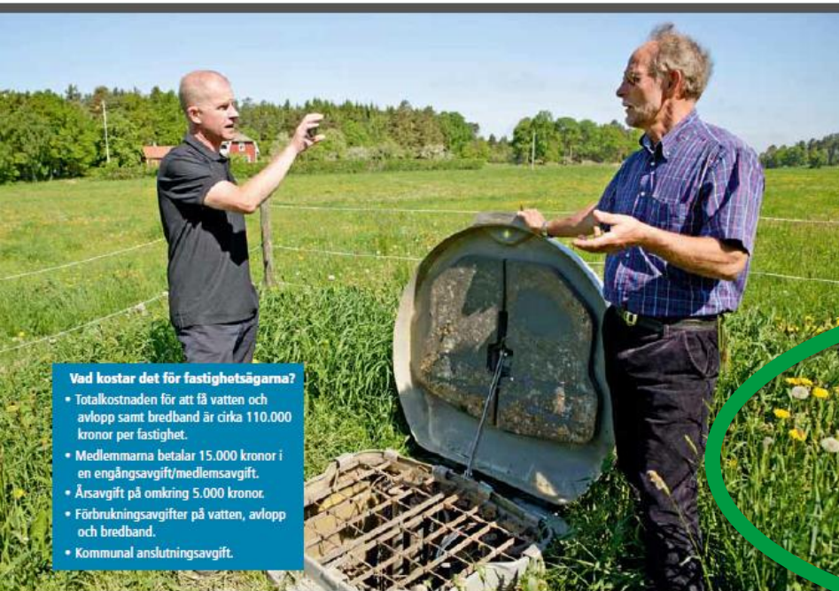
Fyra Flygt TOP-modulstationer samlar upp avloppsvattnet på Källandsö och pumpar det vidare till det kommunala avloppsnätet.
