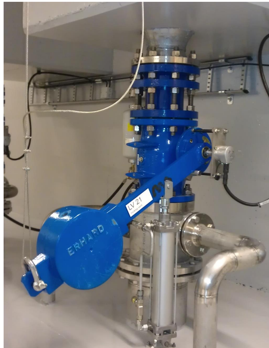
Rana nye vannbehandlingsanlegg
