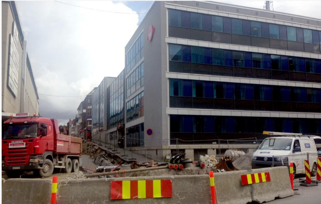
Prøver som er tatt av drikkevannet viste spor av E.coli-bakterier. FOTO: ANETTE TORJUSEN/NRK
