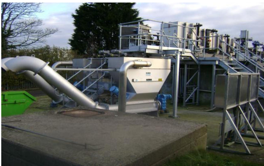
HUBER Vaskepresse WAP® SL – Utvendig installasjon
