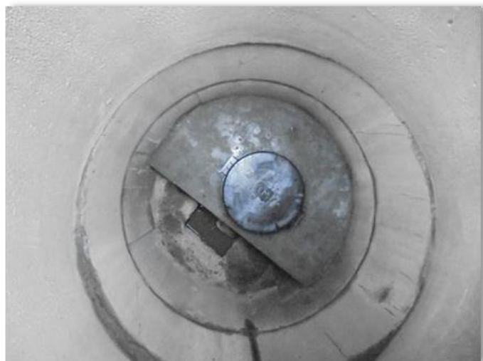
Tett lokk SP-ledning
