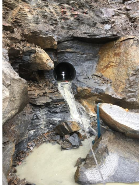
Stålwire for inntrekking av vann ledning
