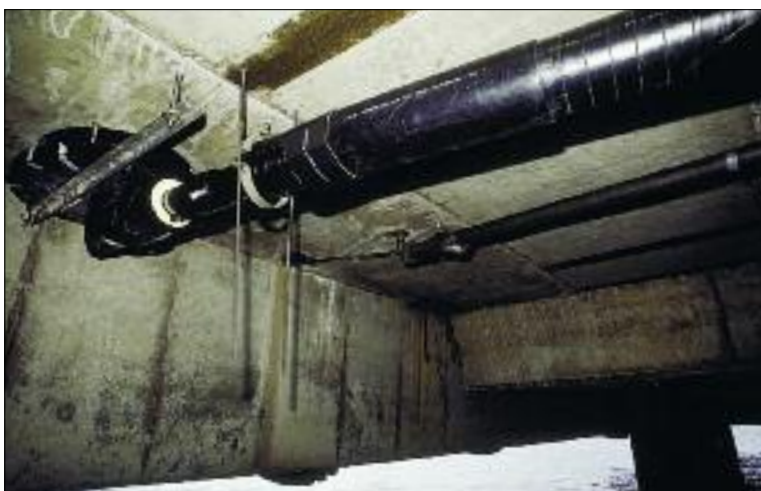
Isovarmledning under Aker brygge
