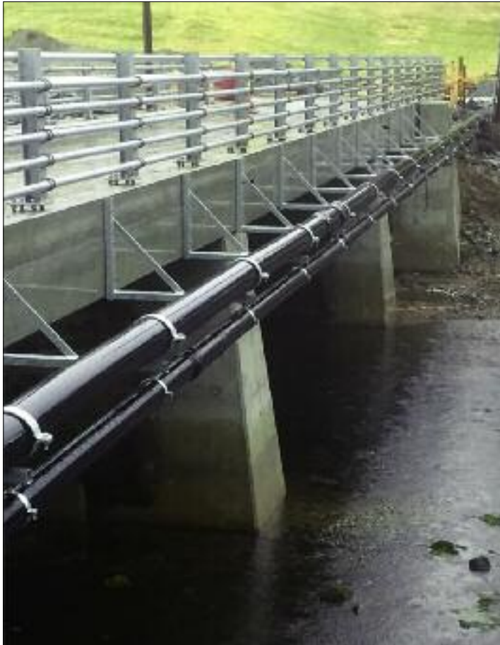
Overføringsledning med vann og avløp, Tømmernes bro, Os kommune
