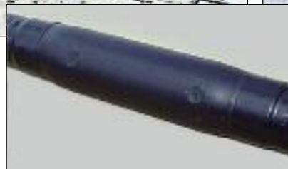
Ferdig koblet og krympet skjot
