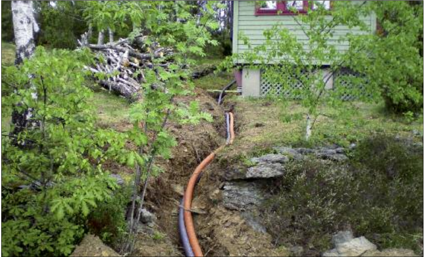
Eksempel på Isoterm vann og trykkavløp i grunne grøfter
