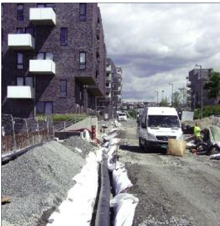
Isovarm som både vann- og avløpsledninger for større boligprosjekt på Sørenga i Oslo
