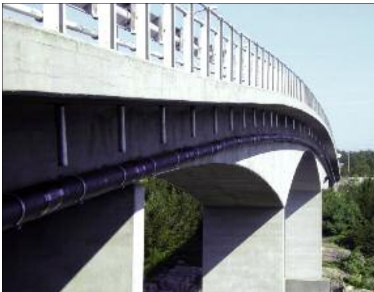
Ulvesund i Øygarden med Isovarm rørledning
