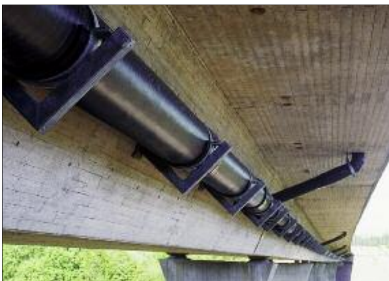
Vestfold, motorveibru med Isovarm overvannsledning
