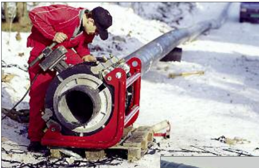
Speilsveising av PE trykkrør
