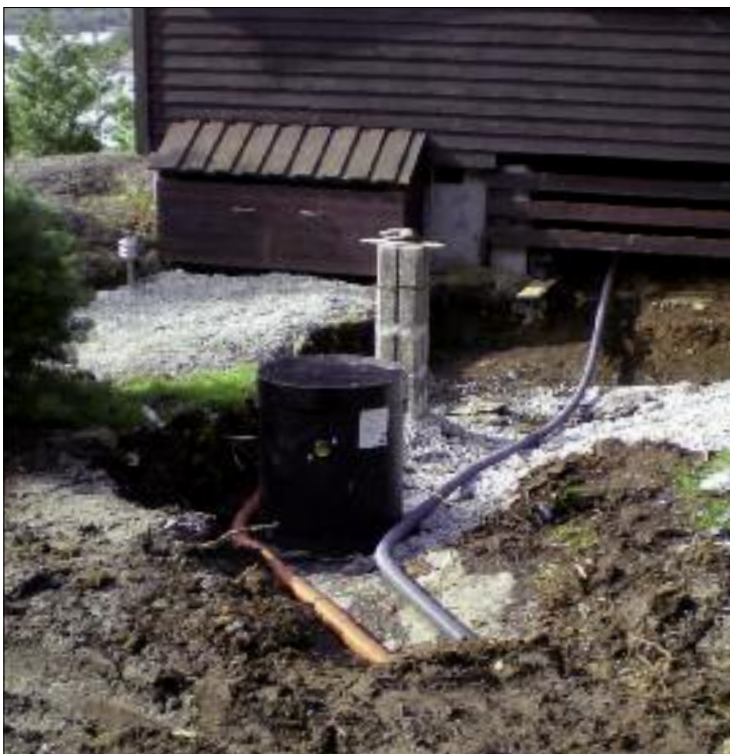
Eksempel på Isoterm vann og trykkavløp i grunne grøfter
