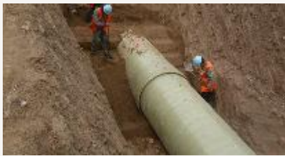
IVAR – Ny hovedvannledning vest
