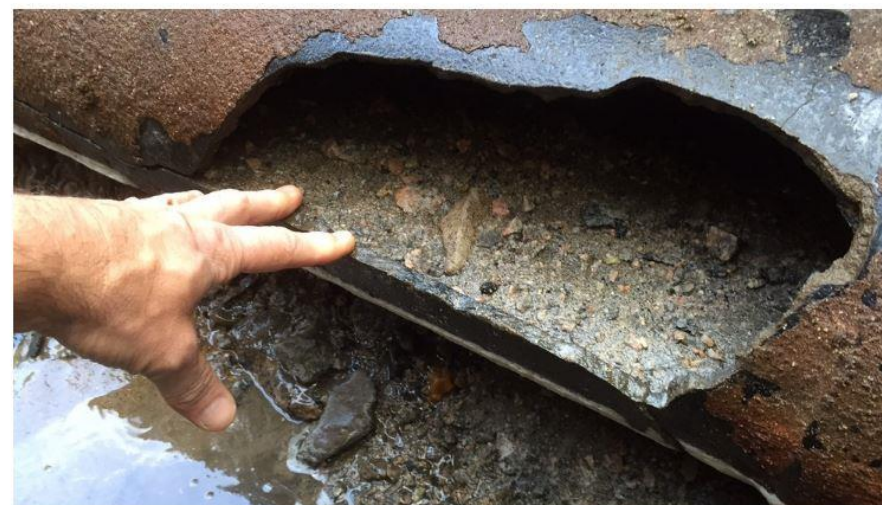
MANDAL: Gamle vannrør i støpejern fra 1867.
